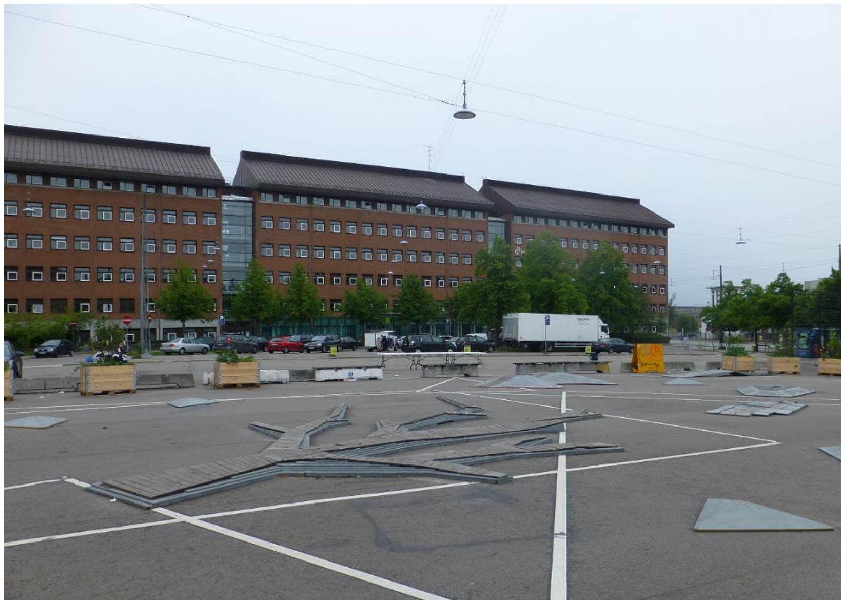
ATP's bygning på sydsiden af pladsen, der bl.a. huser MOVIA og Politistation
