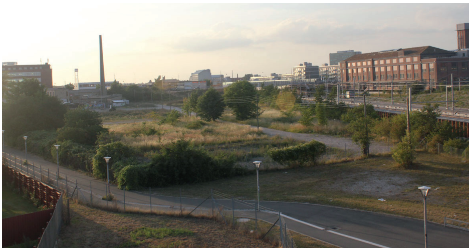
Frejas ejendom ved Følager set fra Ny Ellebjerg Station. Her er næsten al bebyggelse nedrevet.
